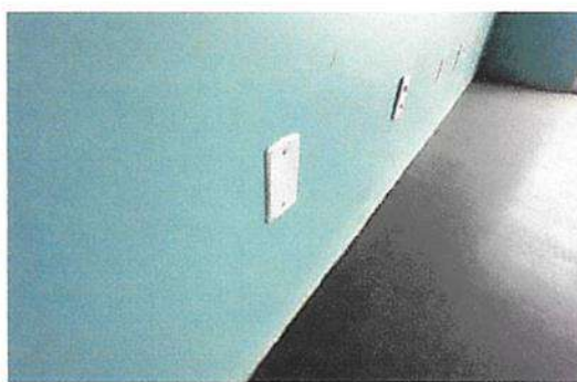
Substituir tampas cegas por Tomadas RJ 45
